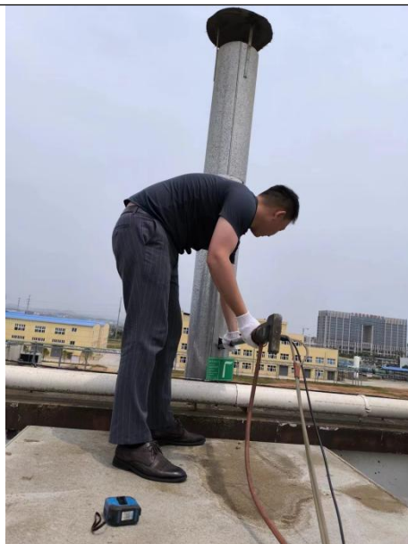
3#车间破碎粉尘排气筒DA004采样
